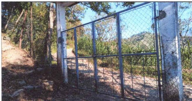
**Foto 5: SE OBSERVA DETERIORO DE LA PUERTA PRINCIPAL POR LO QUE SE HARAN LOS CAMBIOS QUE CORRESPONDEN**
