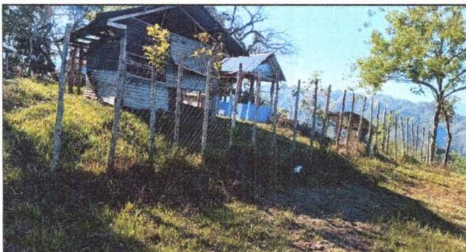
**Foto 3: SE OBSERVA DESLIZAMIENTO DE TIERRA EN LA BASE DE LA MALLA POR LO QUE SE HARÁ UN MURO DE CONTENCION**
